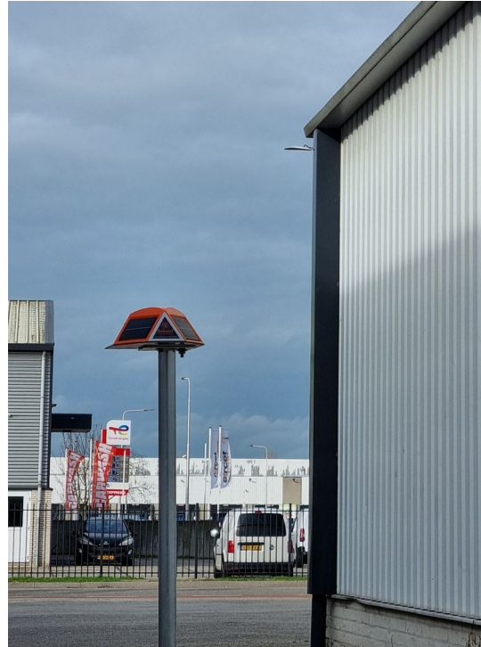
Basis te dichtbij het gebouw (slecht ontvangst én te weinig zonlicht)
